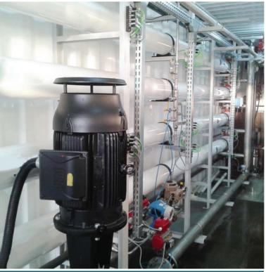
Nanofiltração é um processo crossflow de separação por membrana que é capaz de remover determinados sais, parte dos compostos orgânicos e partículas com peso molecular no range de 300 a 1000 daltons.
